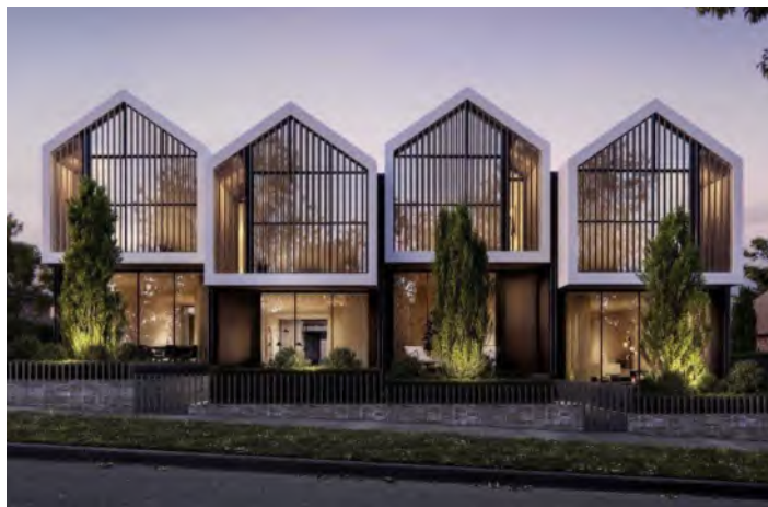
Dæmi um húsagerðir, fjölbreytt byggingarform og -efni.
