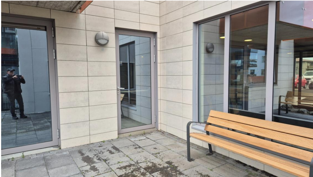
Mynd 6. Inngangssvæðið og aðkoma að hurð.
