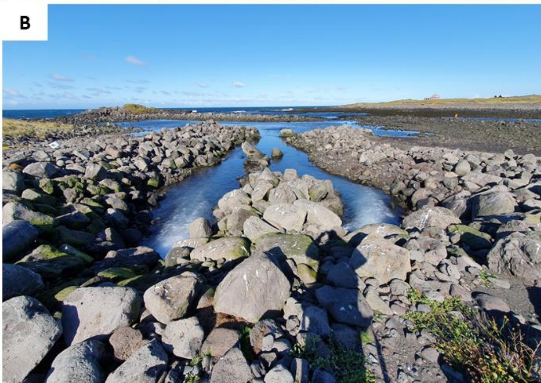
Mynd 1.5. Útrás affallsvatns fiskeldis Benchmark Genetics Iceland við Kalmanstjörn. A) Útrásarop affallslagna, séð úr vestri með fiskeldisstöð Benchmark Genetics Iceland í bakgrunni. B) Útrásir affallslagna, séðar úr austri af útrásarstokknum. Myndir: SG.
