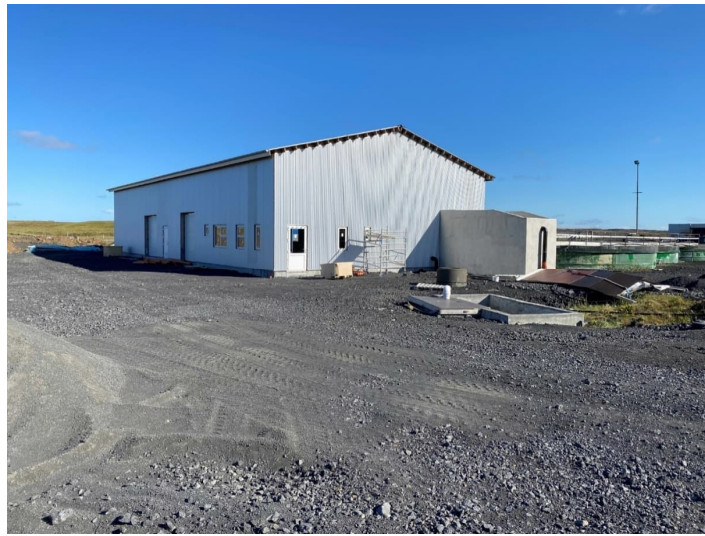
Mynd 3.4 Sláturhús (nr. 6) sem verið er að byggja.
