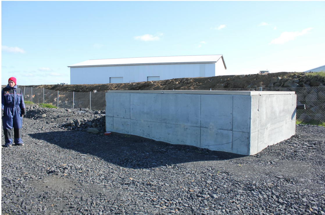
Mynd 3.13 Þró sem tekur við öllu frárennsli frá eldisstarfseminni við Kalmanstjörn. Vatn í þrónni fer um fiskgildru áður en því er veitt í fjöruna.
