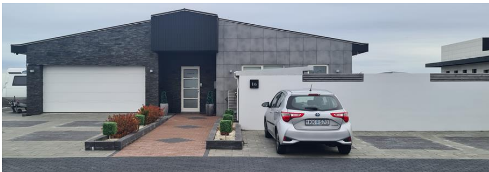
Mynd 7: Völuás 16, stoðveggur fyrir framan hús.
