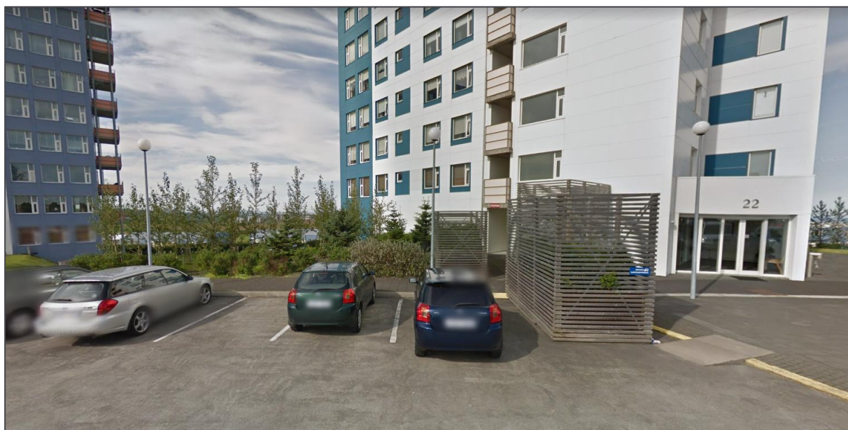
Mynd 19 Dæmi um gróður og skjólveggi staðsett á vindasömum svæðum við horn bygginga. Hér er verið að draga úr hraða á vindi sem streymir niður hlið byggingarinnar og fer í kringum horn hennar þar sem inngangurinn er staðsettur. © Google Maps. Blásalir í Kópavogi.
