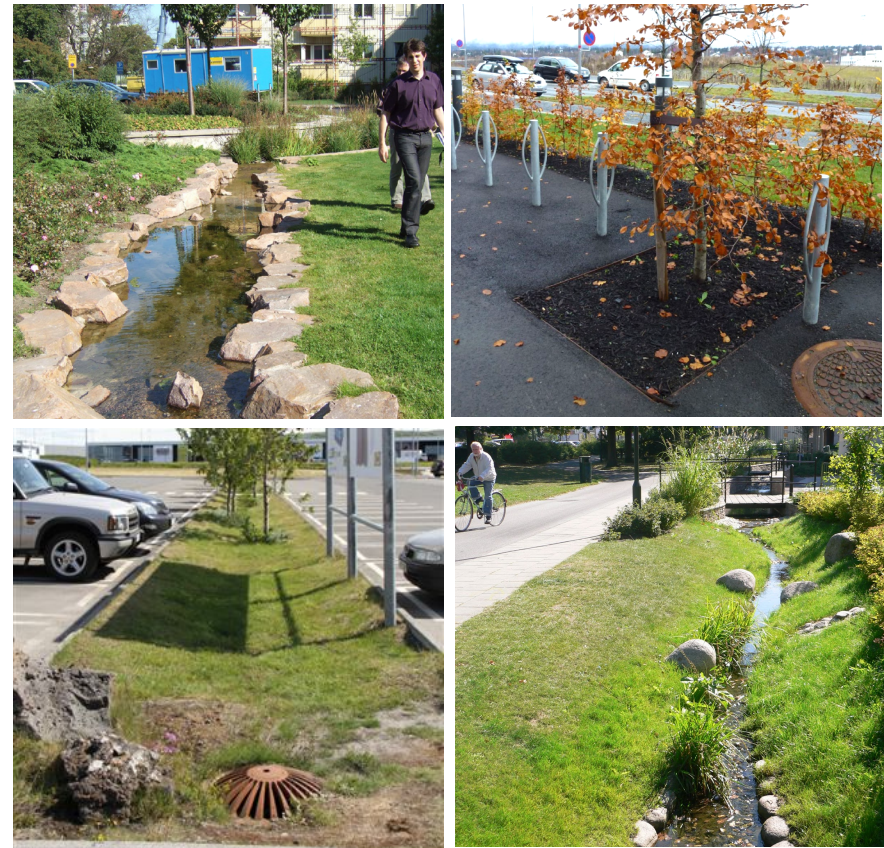
Mynd **: Dæmi um blágrænar ofanvatnslausnir í þéttbýli. Fjölbreyttar lausnir standa til boða við útfærslu blágrænna sem hluta af landslagshönnun og fegrun umhverfisins og sem hluta af leik- og dvalarsvæðum í almenningsrýmum og á einkalóðum.
