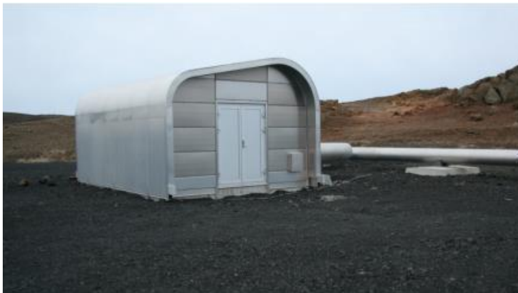
Mynd 3-2 Borholuhús við Reykjanesvirkjun.
